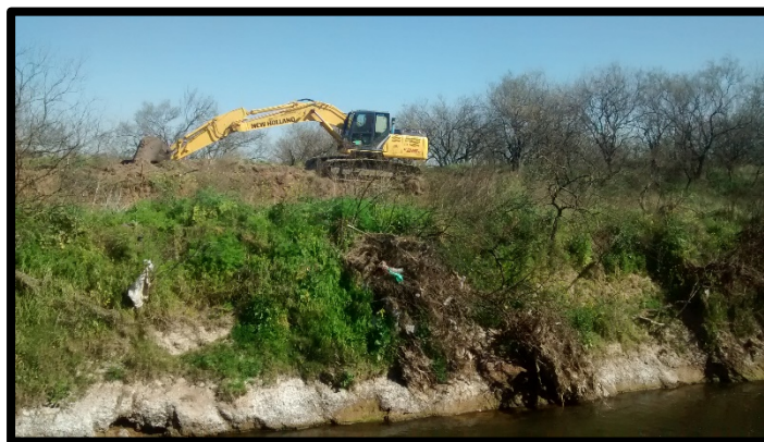
Ejecución de banquina con Retroexcavadora New Holland 215E
