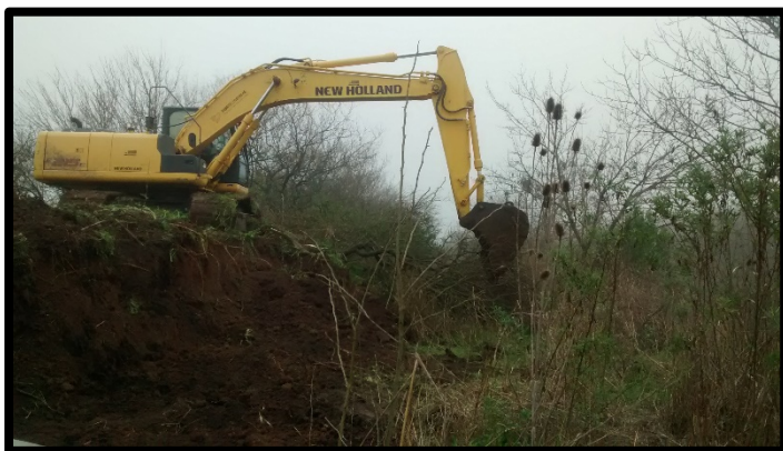
Ejecución de banquina con Retroexcavadora New Holland 215E
