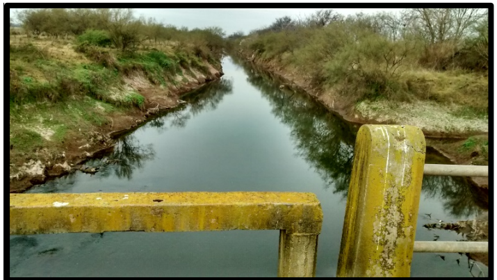
Estado inicial Arroyo Las Totoras (sin intervención)
