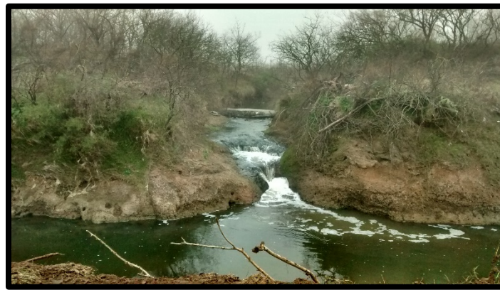
Desagües que llegan desde el campo hacia el Arroyo
