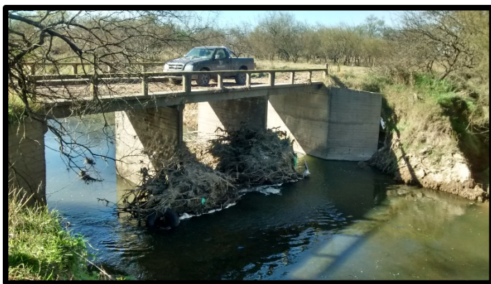
Tercer Puente (Km 9,35) – Camino del Corralito
